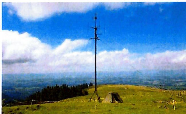
Site éolien potentiel du Schwyberg. Source : SdE
