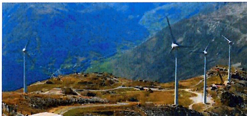
Parc éolien de Güttsch (UR). Source : Suisse Eole
