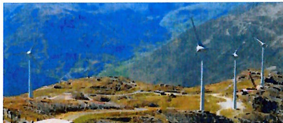
Parc éolien de Güttsch (UR). Source: Suisse Eole
